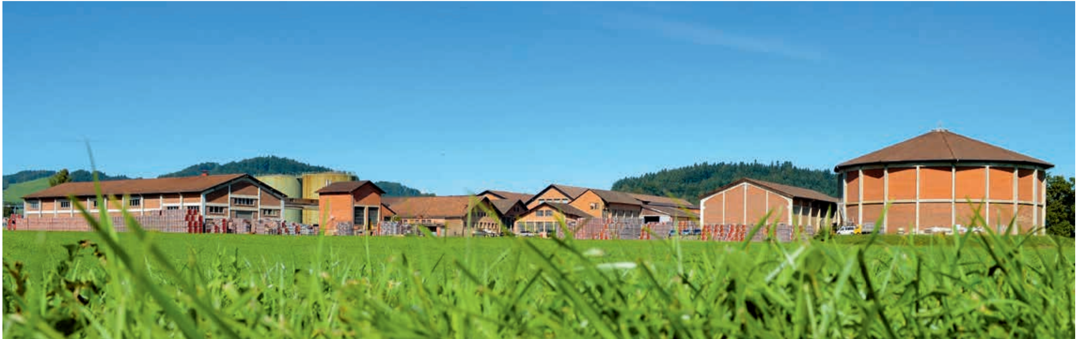
Die Südansicht der AGZ Ziegeleien AG in Gettnau. Fotos zvg
