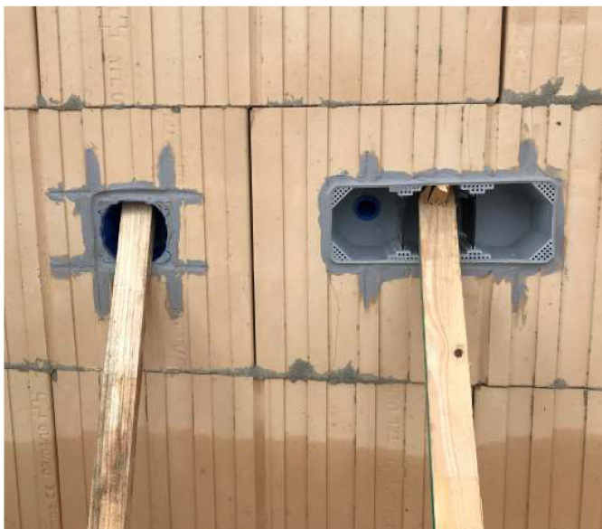
Steckdosen und Leerrohre werden vor dem Verfüllen ins SuonOptimo-Mauerwerk eingebracht.
